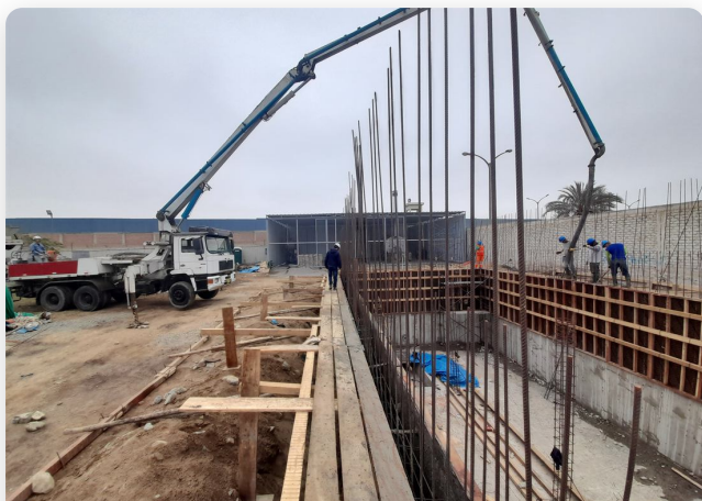
EXCAVACIÓN Y MOVIMIENTO DE TIERRAS
