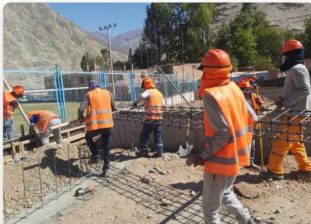
CUADRILLA REALIZANDO ACABADO DE LOSA
