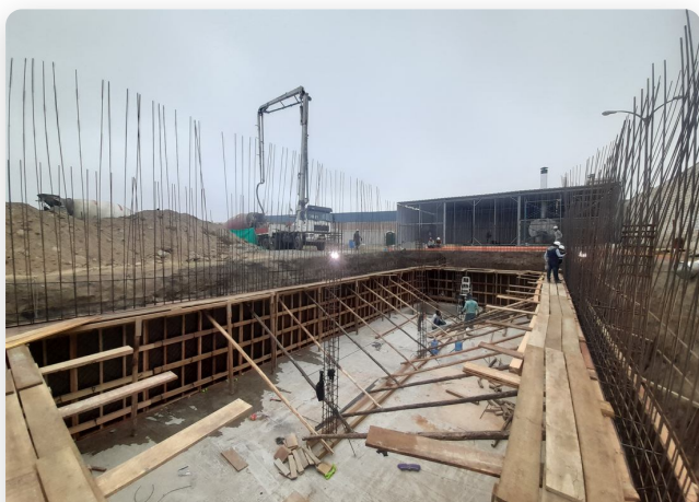
ESTRUCTURAS DE CONCRETO ARMADO
