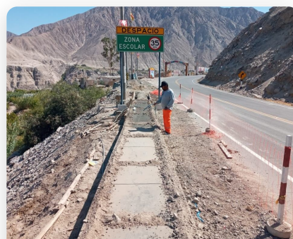
VEREDA PEATONAL JUNTO A CARRETERA
