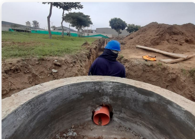
INSTALACIÓN DE ESTRUCTURAS DE SANEAMIENTO
