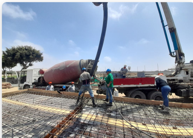
HABILITACIÓN DE CIMENTACIONES
