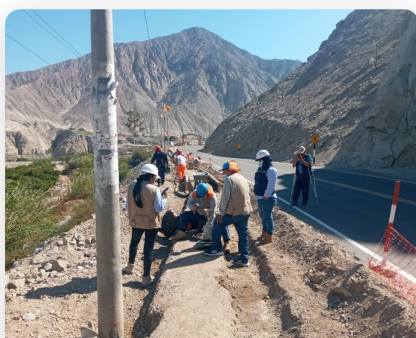
OBRA VIAL EN ZONA DE SIERRA
