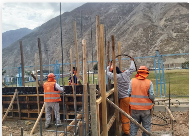
TRABAJOS EN ZONA DE SIERRA
