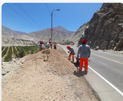
TRABAJOS DE BERMAS Y ACCESOS
