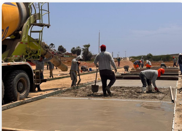
HABILITACIÓN DE ENCOFRADO Y ACERO
