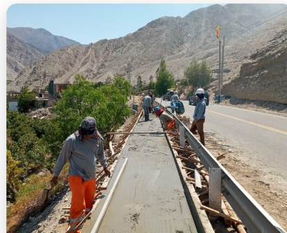
HABILITACIÓN DE VEREDAS EN CARRETERA
