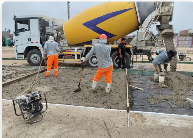
CUADRILLA EN FRENTE DE OBRA
