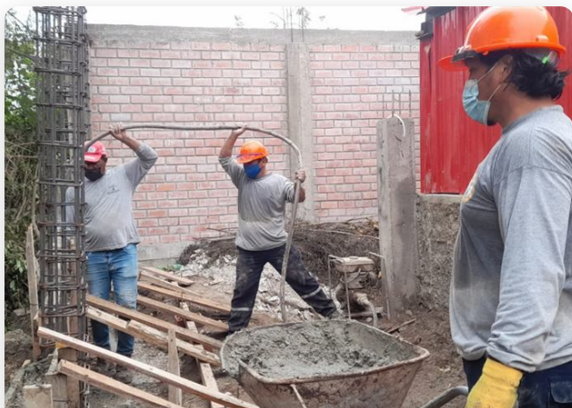
HABILITACIÓN DE ACERO Y ENCOFRADO
