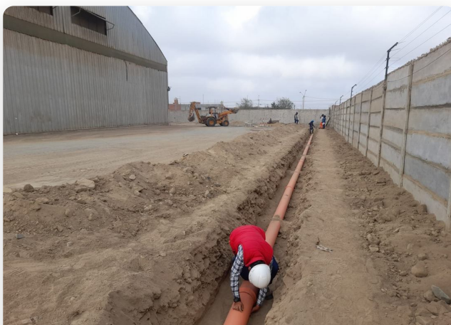
MATERIAL DE TUBERÍA ACOPIADO EN OBRA
