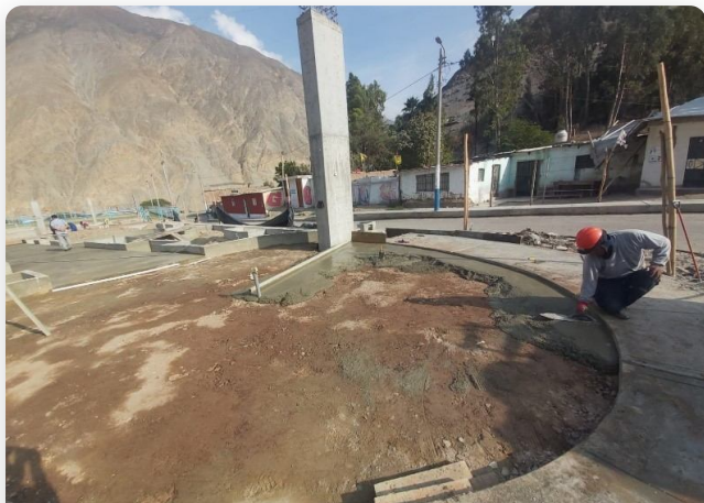
BOMBEO Y VACIADO DE CONCRETO
