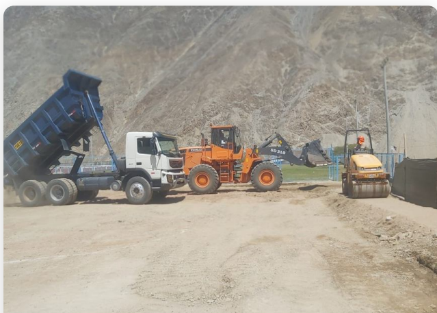
VACIADO Y ACABADO FINAL
