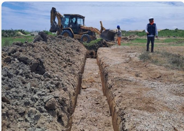
EQUIPO TÉCNICO EN FRENTE DE OBRA
