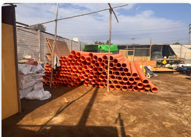
EXCAVACIÓN PARA REDES DE AGUA Y DESAGÜE
