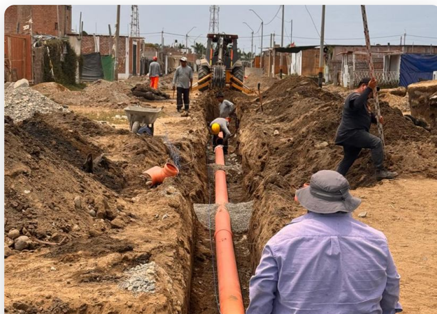
TENDIDO DE TUBERÍA EN ZANJA
