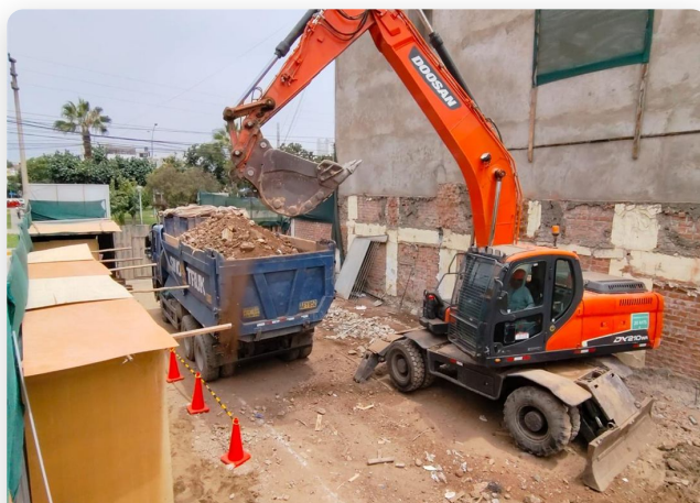
FRENTE DE OBRA EN EJECUCIÓN
