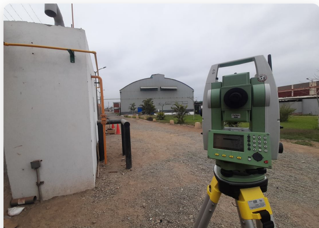
ESTACIÓN TOTAL EN CAMPO
