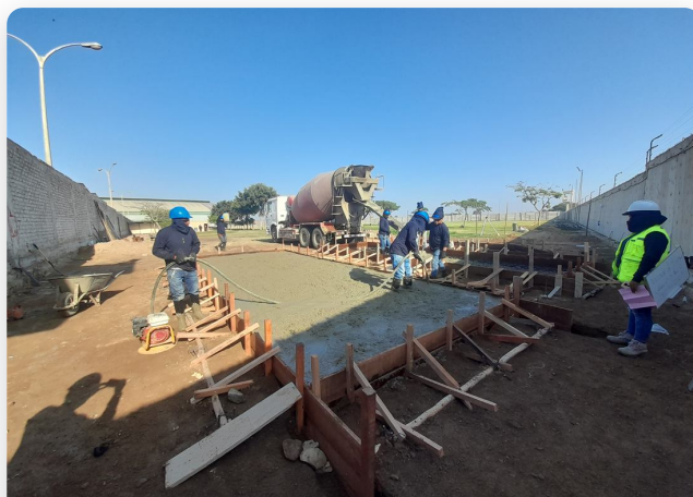
VACIADO DE CONCRETO EN OBRA
