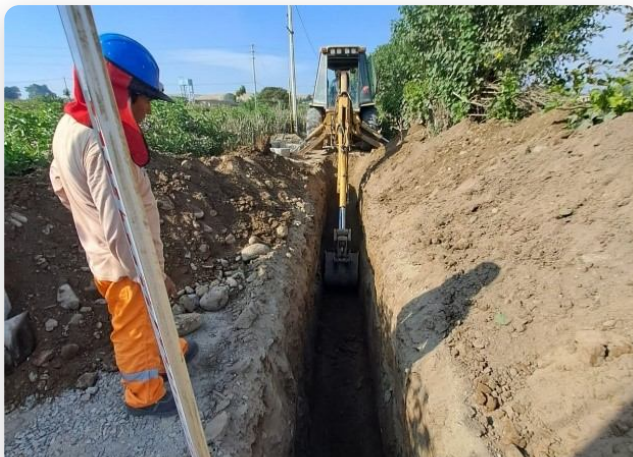
COLOCACIÓN DE TUBERÍA PRINCIPAL
