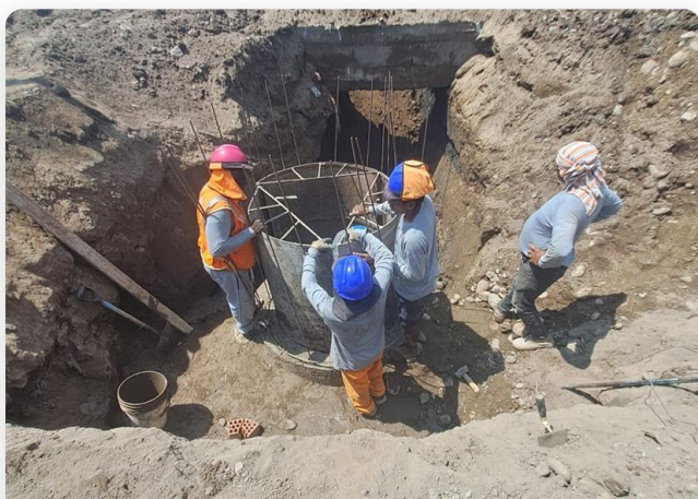
SUPERVISIÓN DE INSTALACIÓN DE RED
