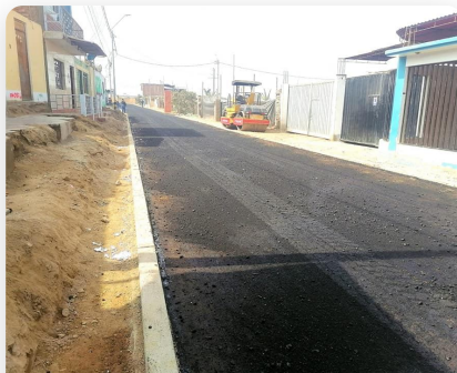
PISTA ASFALTADA TERMINADA
