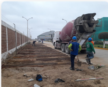
VACIADO DE PAVIMENTO
