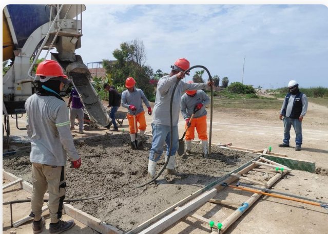
ESTRUCTURA CIRCULAR EN PROCESO
