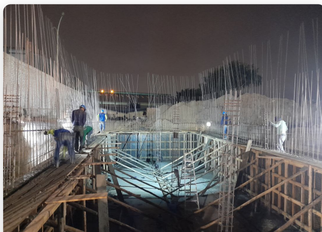
BOMBEO DE CONCRETO EN CAMPO
