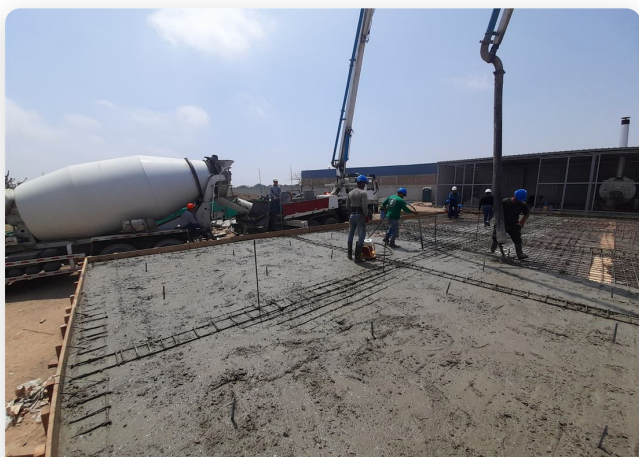
TRABAJOS EN LOSAS Y ELEMENTOS ESTRUCTURALES
